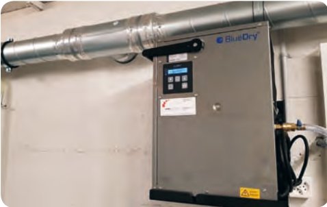
Bauliche Anpassung der Archivlogistik durch Installation einer automatisierten Raumbelüftung und Luftentfeuchtung.
