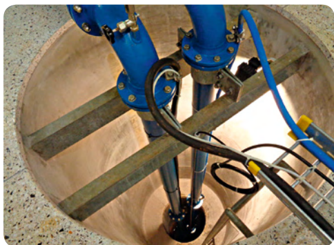
Blick vom Rohrkeller in den Brunnen
